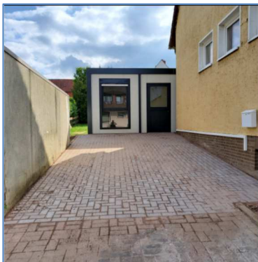
Der neue Zugang
